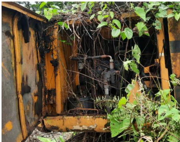
BOMBA HIDRAULICA PILOTO
